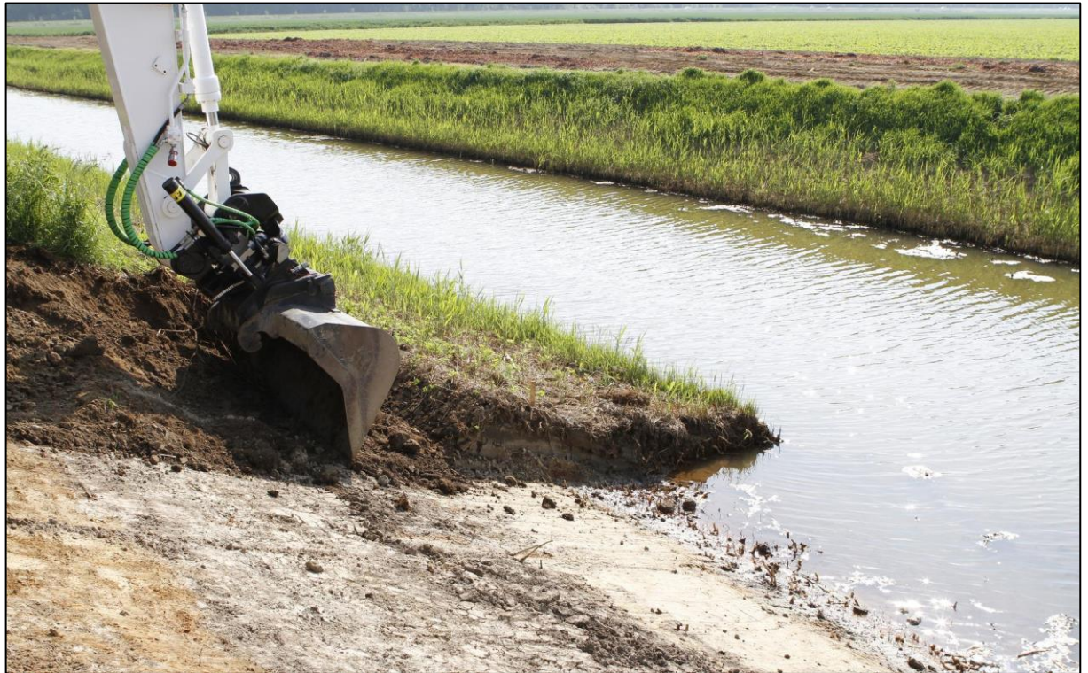
Figuur 12: De aanleg van duurzame oevers in Flevoland Foto: Waterschap Zuiderzeeland
